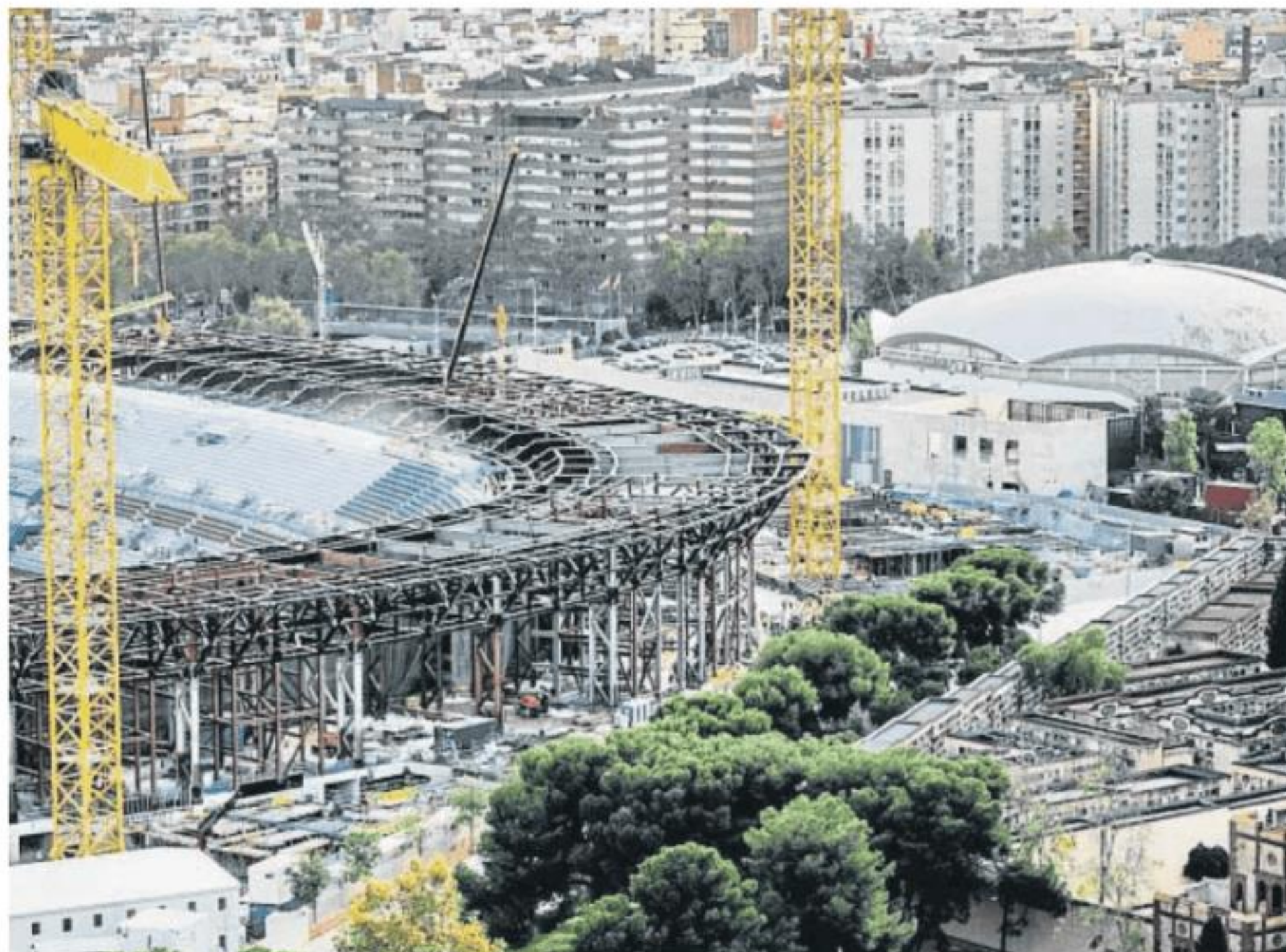
Imagen aérea de las obras del Spotify Camp Nou, que incorporará la tecnología HPE
